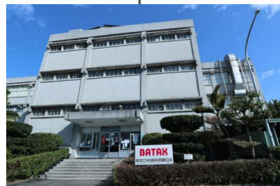
二廠 台中市潭子區南二路28號之1
